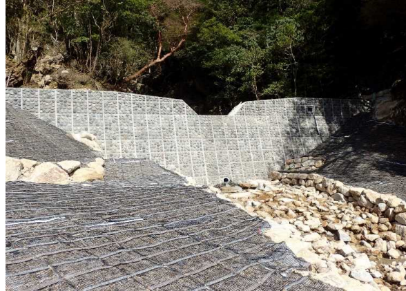
治山ダム(太忠嶽国有林78林班)
