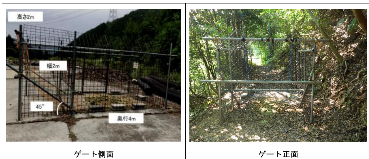
図5 潜り込み式獣類捕獲用ゲート設置状況（和歌山県）
