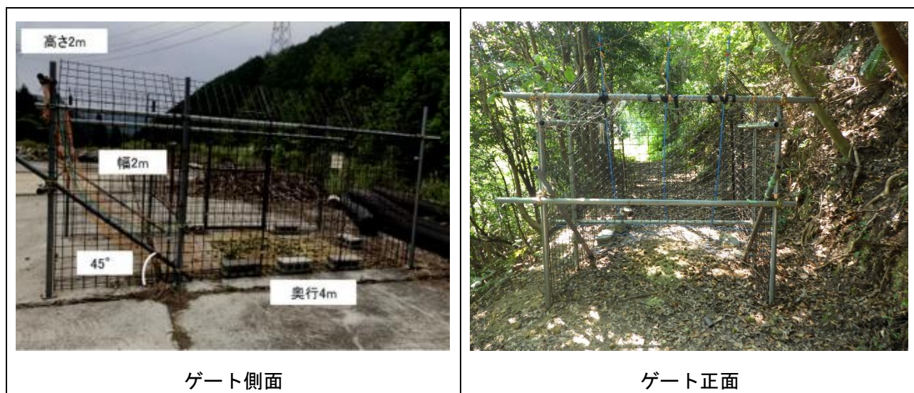
図5 潜り込み式ゲート設置状況
