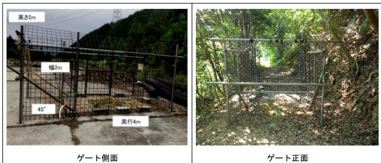
図5 潜り込み式ゲート設置状況
