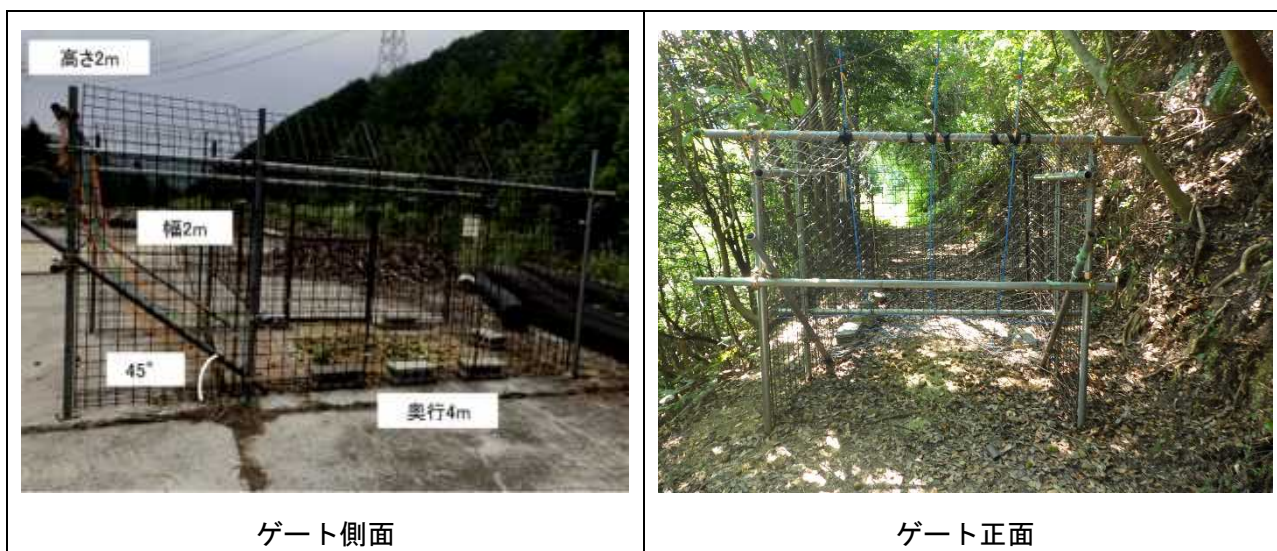
図5 潜り込み式ゲート設置状況
