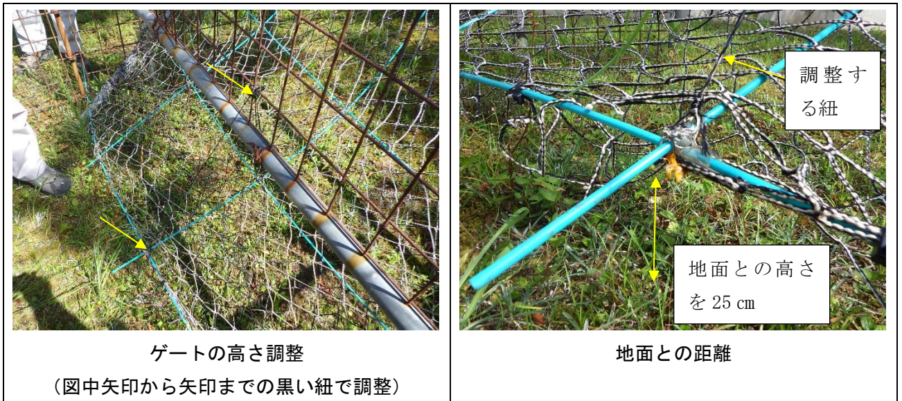
図8 潜り込み式ゲート調整方法
