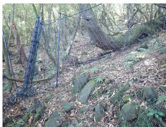
写真 2 土砂流出箇所から離れて移設された柵の入口付近
