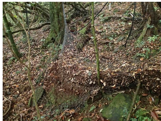
写真 2 柵下部の土砂溜まり
