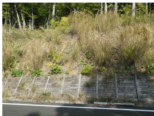
【南部地域の南部林道（平成 25 年度）】
