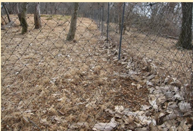
防護柵下部からの侵入防止ネット設置前の状況
