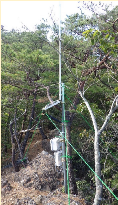
親機設置状況
