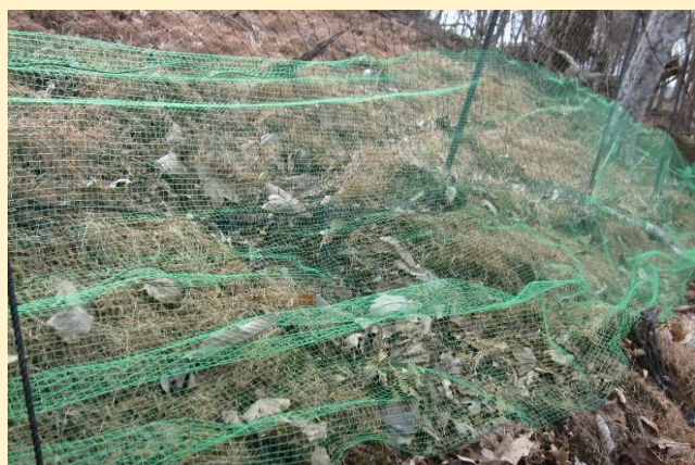
防護柵下部からの侵入防止ネット設置後の状況
