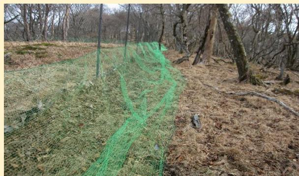
防護柵の最下部から約50cmの位置に低コスト資材のネット(1巻50m幅1.5m)を余裕を持たせ緩く重なるように斜めに設置した状況
