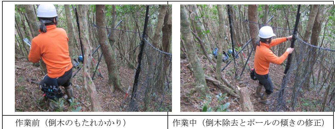
写真 2-エ-9 中間前岳上部
