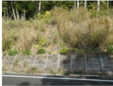
【南部地域の南部林道（平成 25 年度）】
