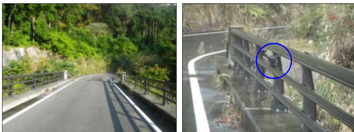
写真写真 2-11-22 「湯川橋」(左側の写真)と自動撮影カメラを設置した欄干(右側の写真)
