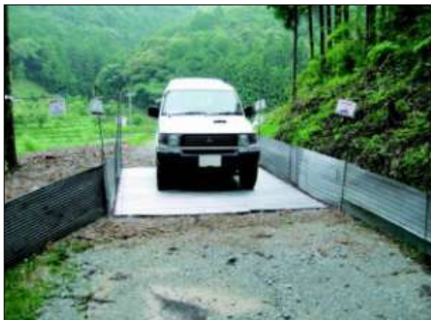
写真 2-11-21 鉄管ロープを活用した 改良型テキサスゲート
