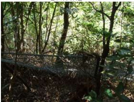
写真 2-6-9 ③落石防護ネット
