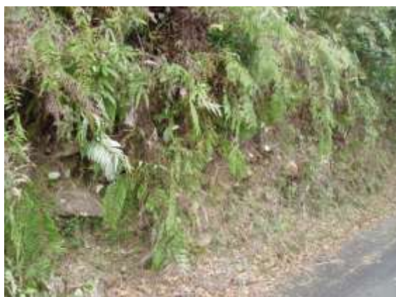
写真 2-6-51 ②道路(法面)
