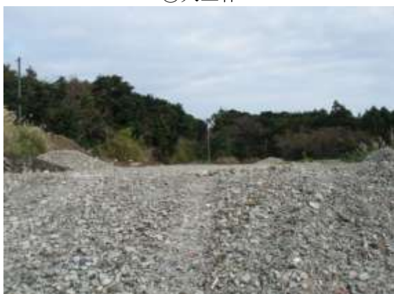
写真 2-6-54 ④-1 残土処理場
