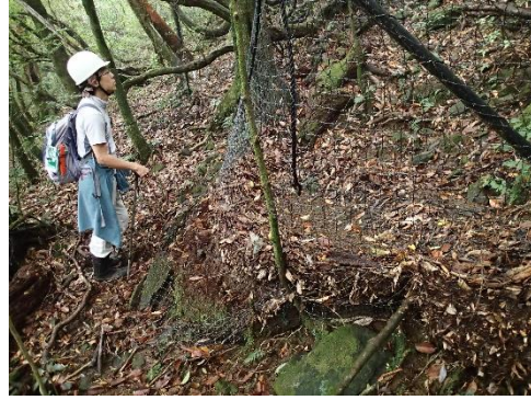
確認時（柵下部の落葉落枝の堆積）
