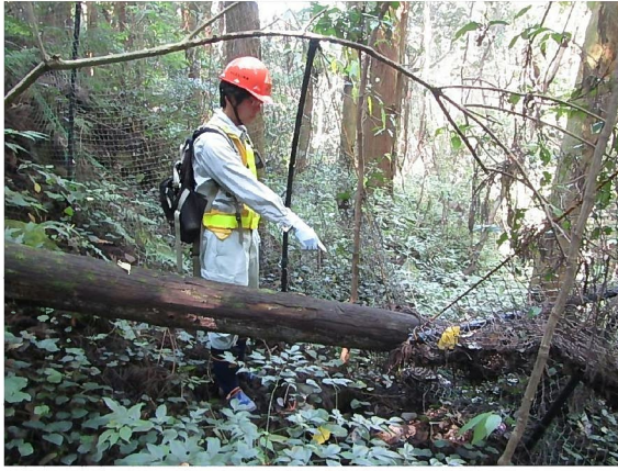
写真 2-5-2-1 水俣市 状況：倒木による破損
