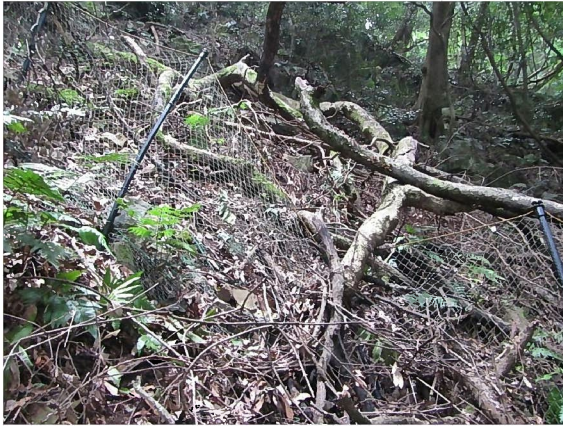
写真 2-5-2-3 大森岳 2092 状況：倒木による破損
