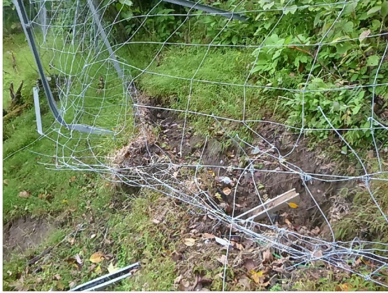
写真 2-5-2-1 天主山 状況：転石による破損
