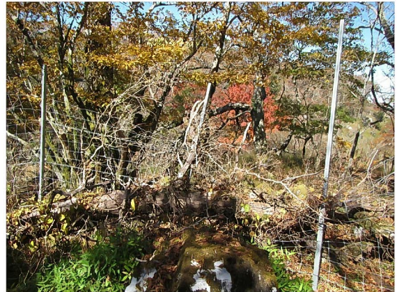
写真 2-5-2-2 白鳥山 状況：保護柵に倒木あり
