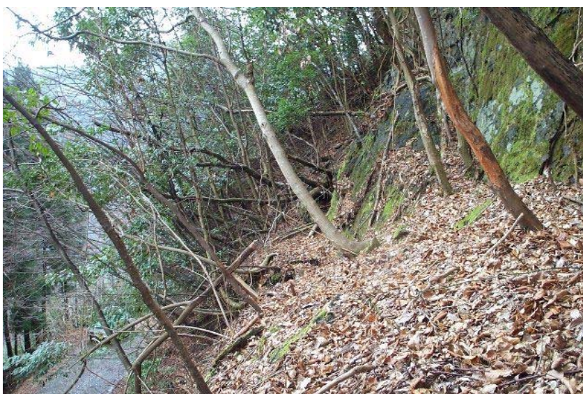
各調査範囲の被害状況（内大臣 地点 No. 11 被害レベル 1）
