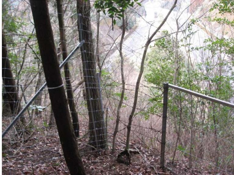
写真 2-9-5-2 恒久柵(写真左)と既存フェンス(写真右)との隙間における有刺鉄線による処置
