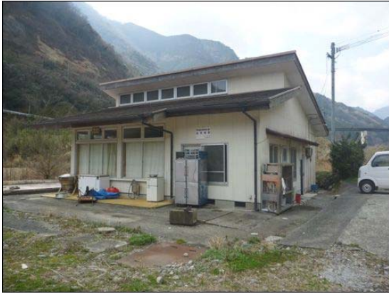
写真 2-3-4-3(1) 五木村猪・鹿解体処理加工施設
