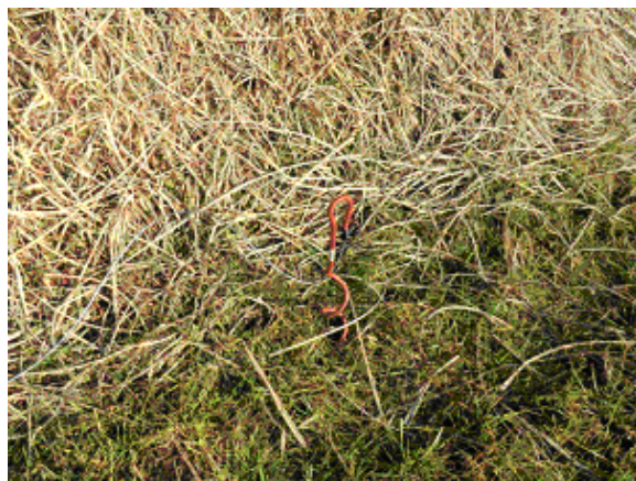
写真 2-4-2-1(11)螺旋杭使用状況
