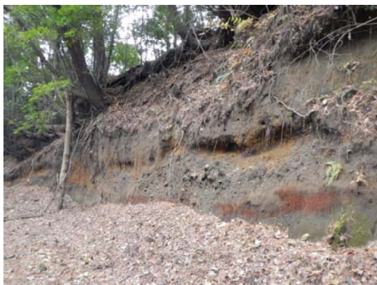
写真 2-1-2-3(1) 崩壊した斜面地
