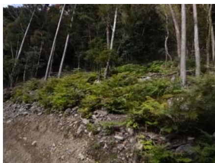
写真 2-4-1-41 保護柵下の状況
