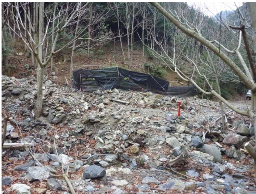
写真 2-3-2-3 遮光ネット設置状況
