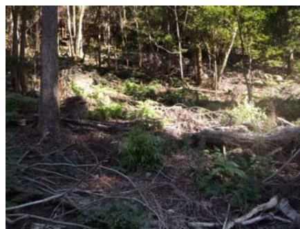
写真 2-4-1-42 保護柵上の状況
