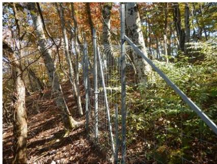
写真 2-3-9 倒木による扉の破損
