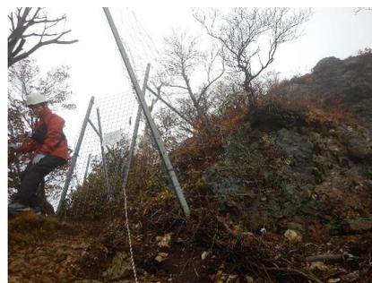
写真 2-3-35 崩落・倒木による北西端の変形 写真 2-3-36 崩落による東端の変形
