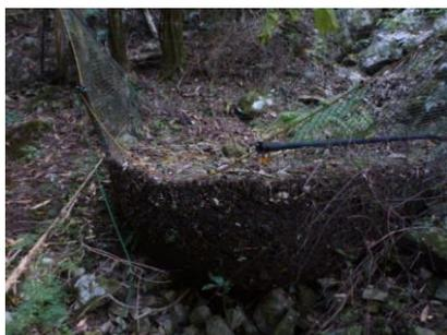
写真 2-3-58 土砂の堆積による破損
