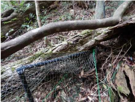
写真 2-3-2-3 大森岳 2092 A 柵 状況：倒木による破損
