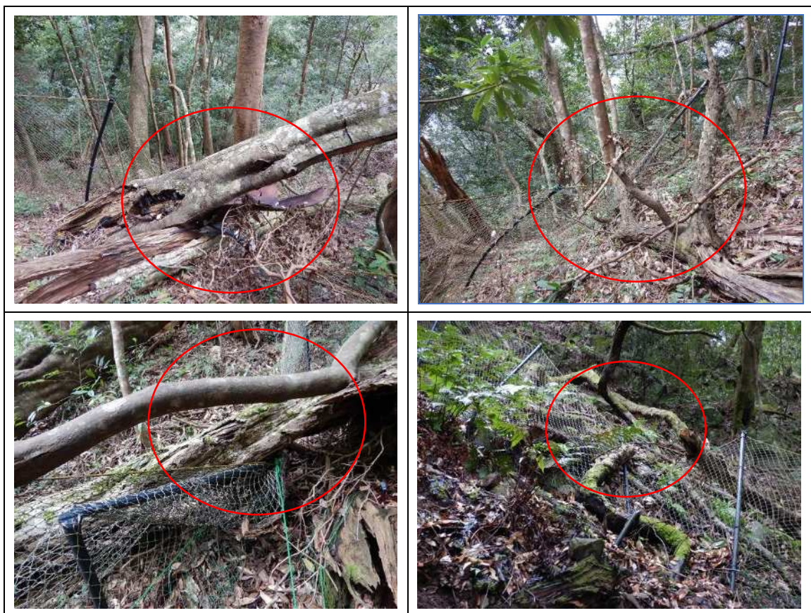
図 2-4-3-5 大森岳 2092 の保護柵の状況（赤円内：倒木による破損箇所）
