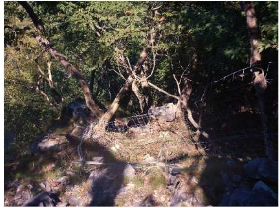
写真 2-3-2-2 洞岳 状況：転石による破損
