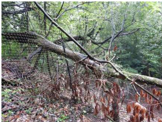
写真 2-3-2-7 小池 状況：倒木による破損
