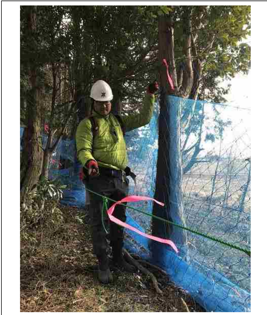
写真 2.5.13 追加設置したネット柵（第一回破損箇所周辺の周辺）
