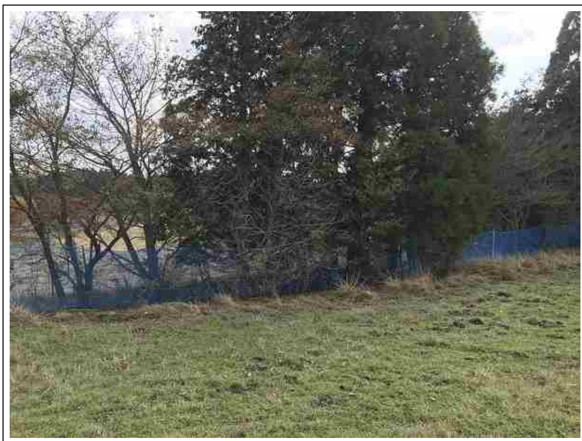
写真 2.5.4 簡易柵の第一次施工
