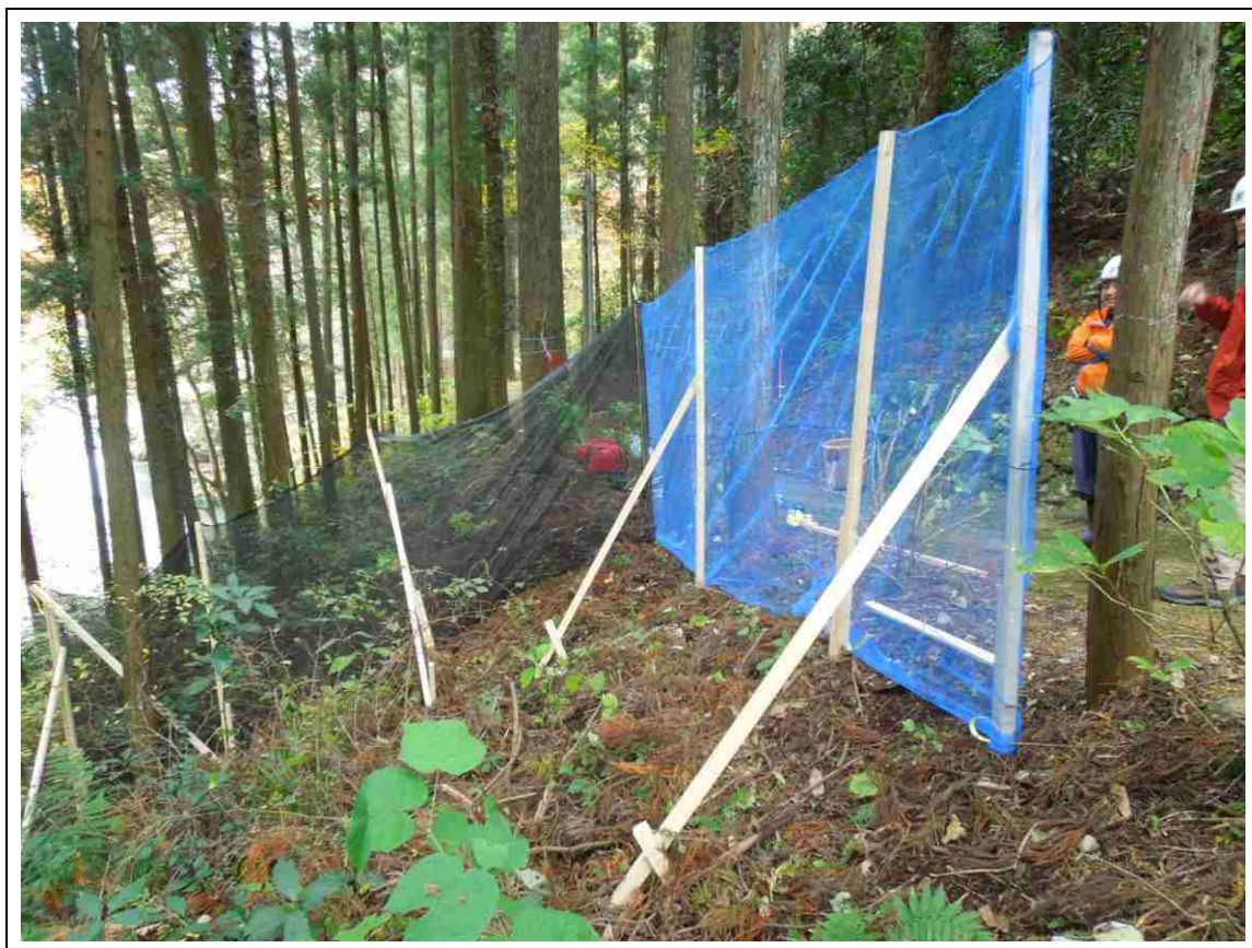
写真 2.5.3 施工試験を試みた簡易柵
