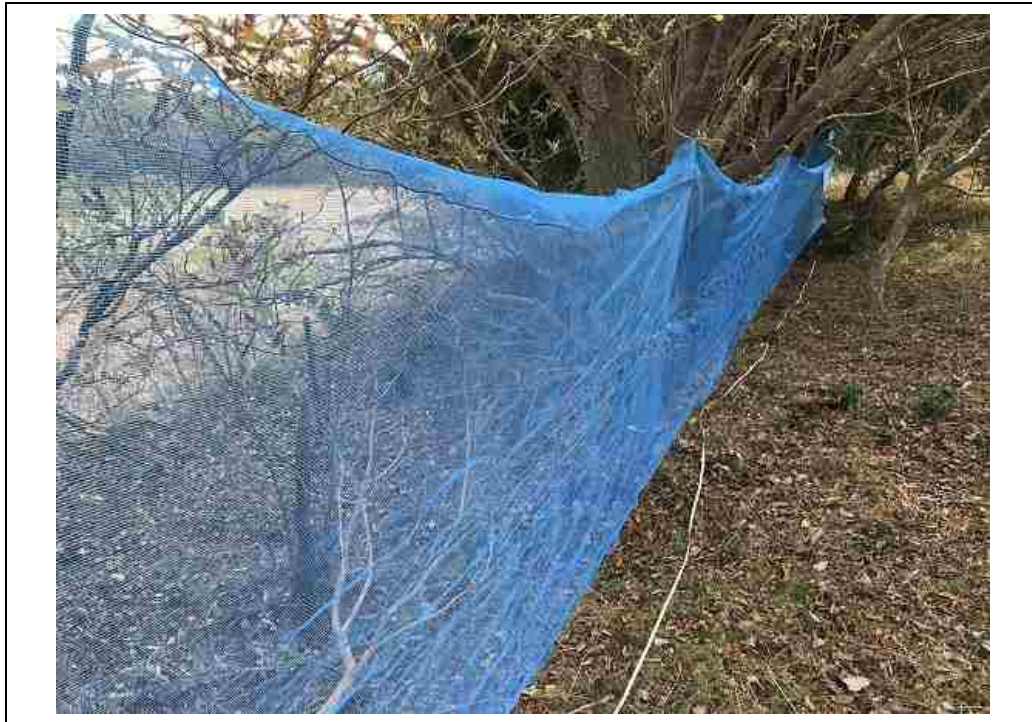
写真 2.5.5 立木を活かした施工
