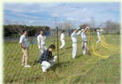
シカ防護ネット設置 実習
