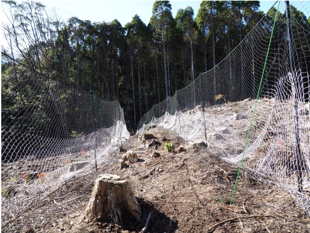
写真 2.4.7 設置した防鹿ネット (af02 より af01 方向へ撮影)
