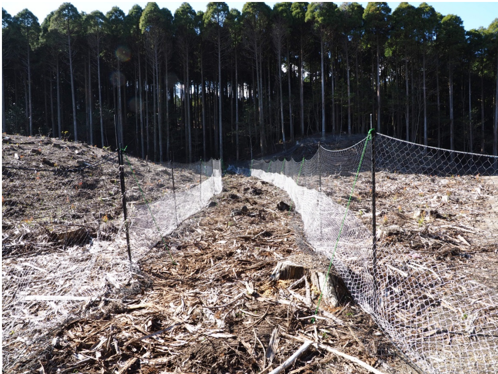
写真 2.4.6 設置した防鹿ネット (af04 より af03 方向へ撮影)
