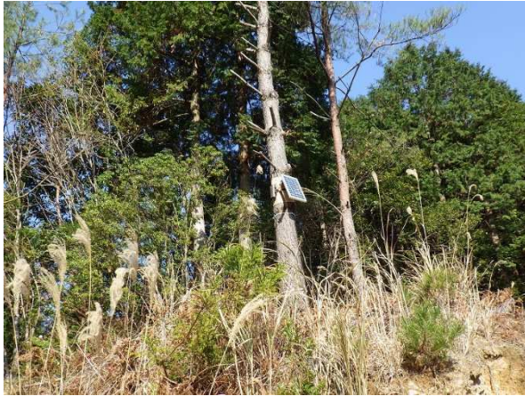
オリワナ中継機へソーラーパネル設置
