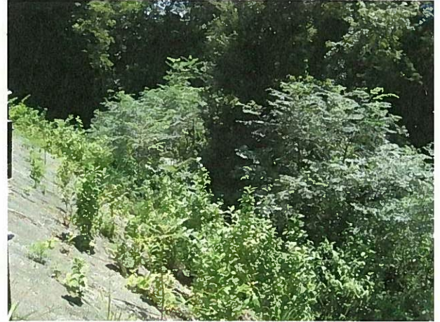
検討箇所道路下側の法面植生の状況嗜好種のカラスザンショウなどが生育し採食被害は軽微
