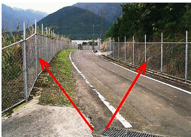
防護柵① 道路沿線における防護・移動防止柵
