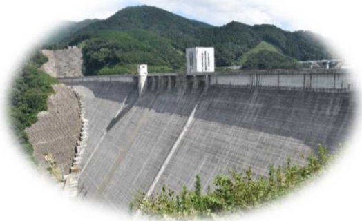
五ヶ山ダム(多目的ダム)
