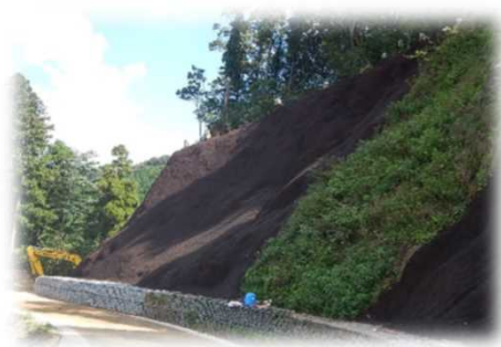
災害復旧工事(成竹林道)
