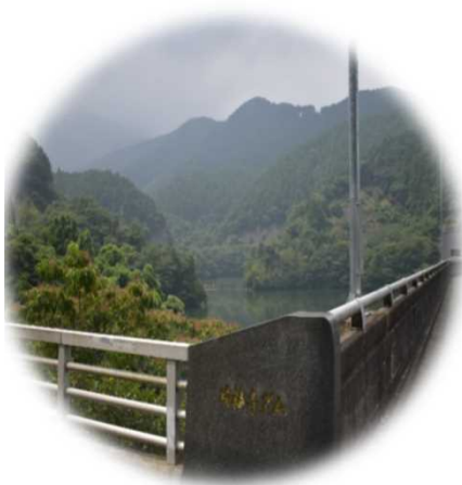
瑞梅寺ダム(多目的ダム)
