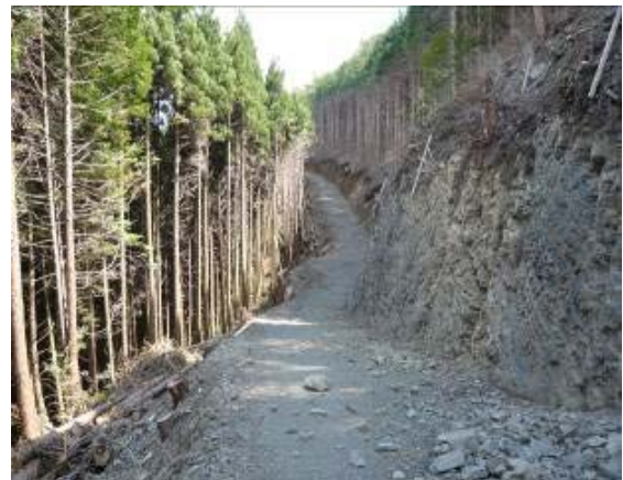
作業道完成状況 (柚園国有林2107林班)
