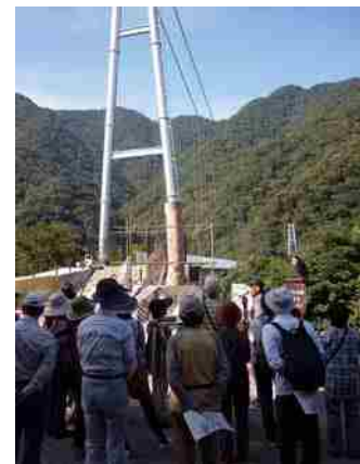
吊り橋完成前のガイド
