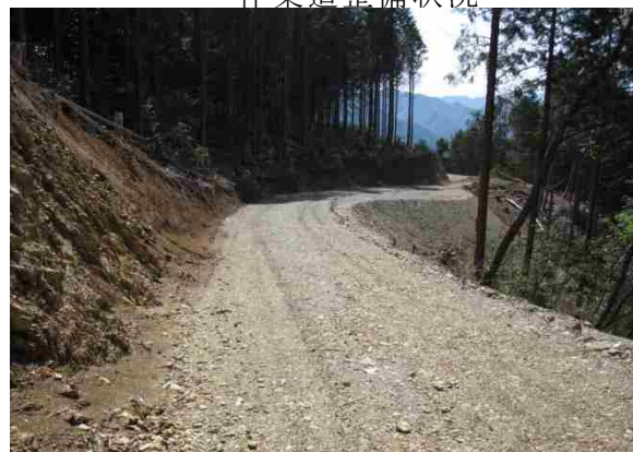
作業道整備状況
