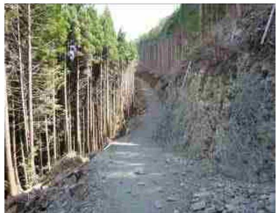
作業道完成状況 (柚園国有林2107林班)
