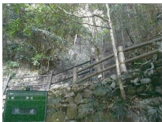
沢地形をした法面からの落石を保護
