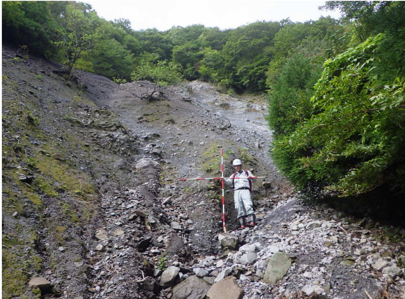
③⑥-崩壊状況
