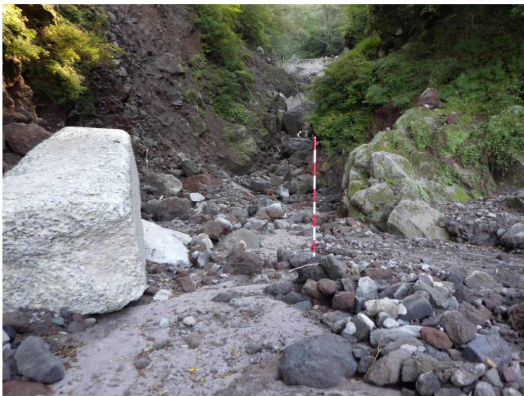
⑪ 溪流の状況(測点No.13 付近) 画像 R0010147
