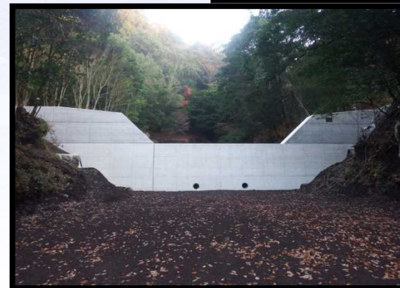
荒襲谷中流 域に完成し た治山ダム
