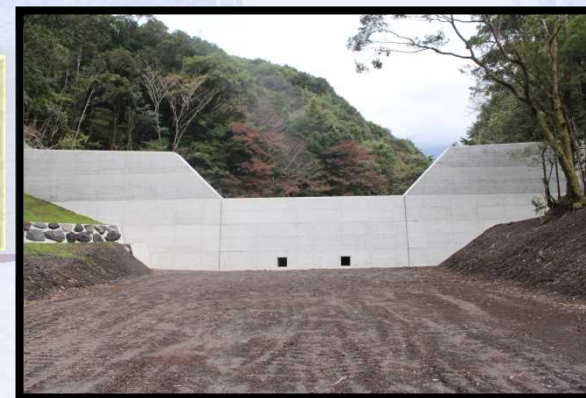
荒襲谷下流 域に完成し た治山ダム
