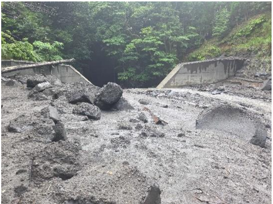
施工箇所の状況
