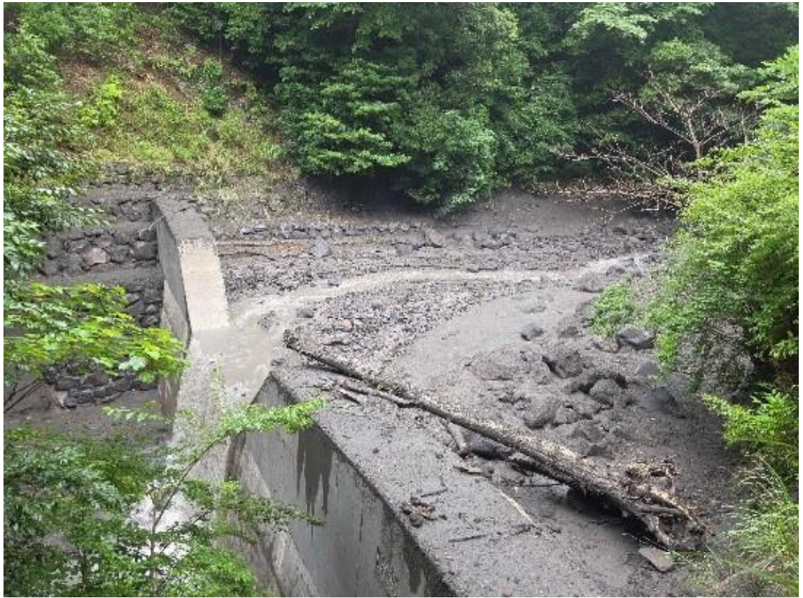
施工箇所の状況
