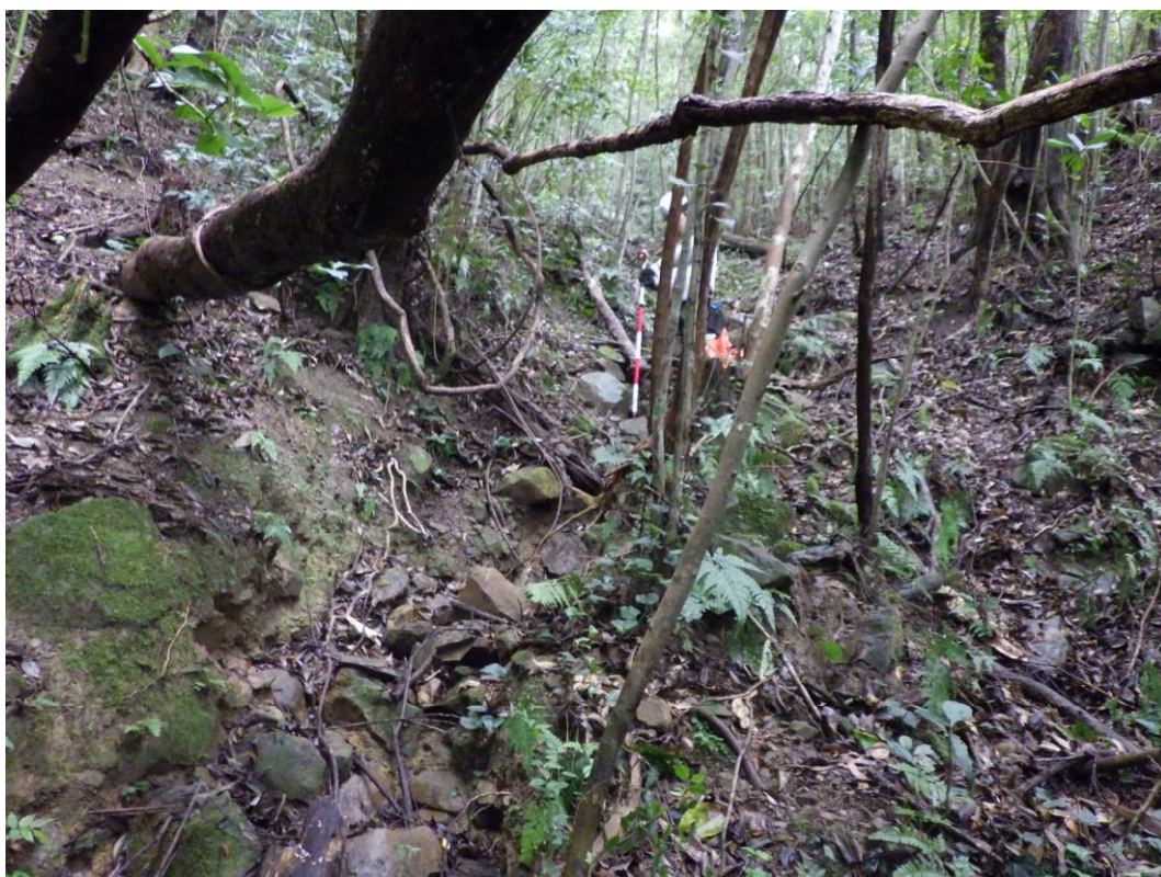
山腹の状況(測点No.15 付近)
