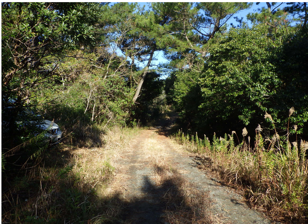
施工箇所の状況（保安林管理道）
