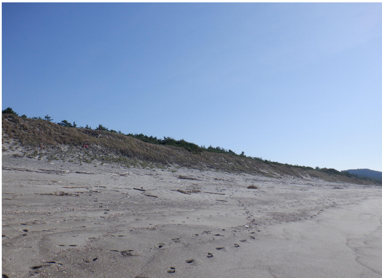
施工箇所の状況（護岸工箇所）
