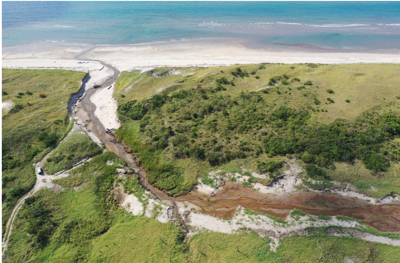
②施工箇所全景(中流付近, 陸側より)
