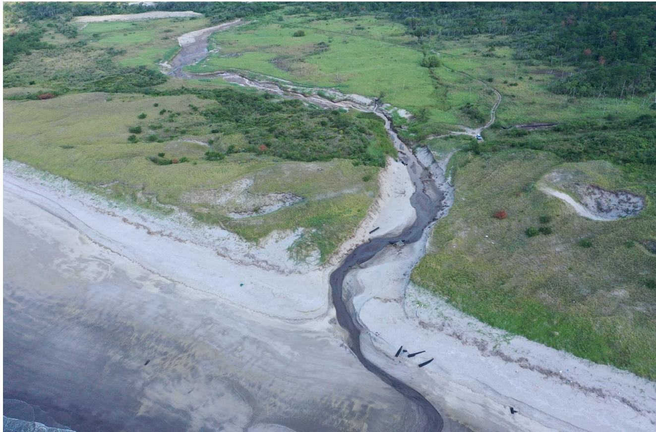
①施工箇所全景(河口付近、海側より)
