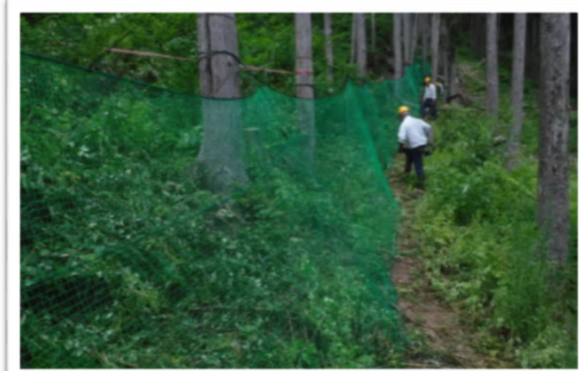
【アニマルネット設置の様子】（すさみ町 宮城川国有林）
