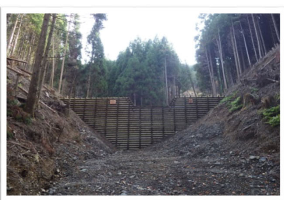
木製品を利用した校倉式木製谷止工
