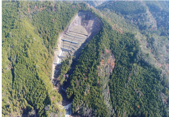
紀伊田辺地区民有林直轄治山事業 山腹工・溪間工（田辺市本宮町）
