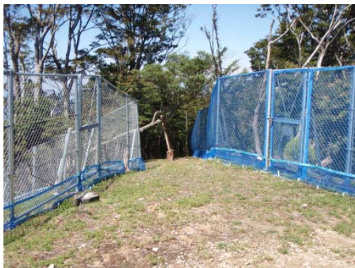
図-5 防護柵・防風ネットの設置
