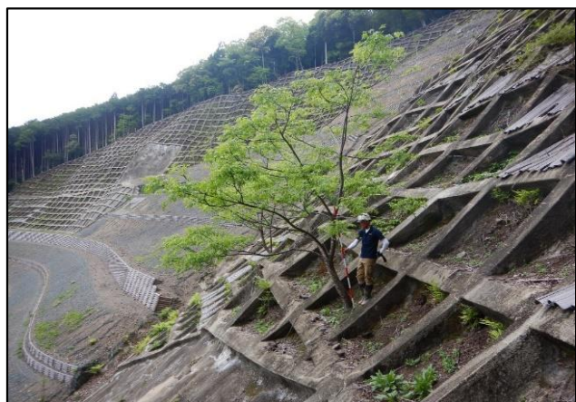
竹被覆工とセンダンの植栽試験地 (田辺市 紀伊田辺地区：下モ谷区域)
