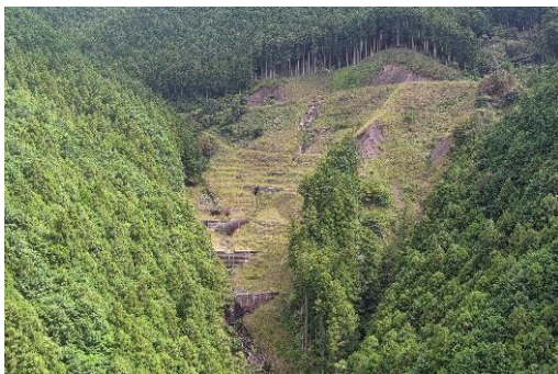
【山腹工】ほんだがいと (田辺市 紀伊田辺地区：本田垣内区域)
