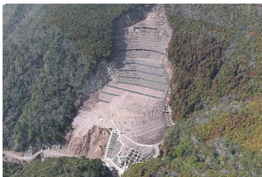
【山腹工】しものたににしがわ (田辺市 紀伊田辺地区：下モ谷西側区域)
