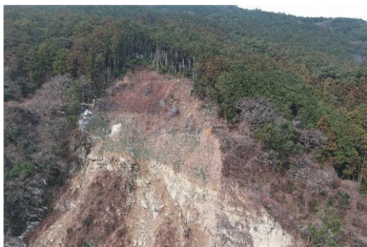
【斜面補強ネット工】 (田辺市 紀伊田辺地区：上秋津区域)
