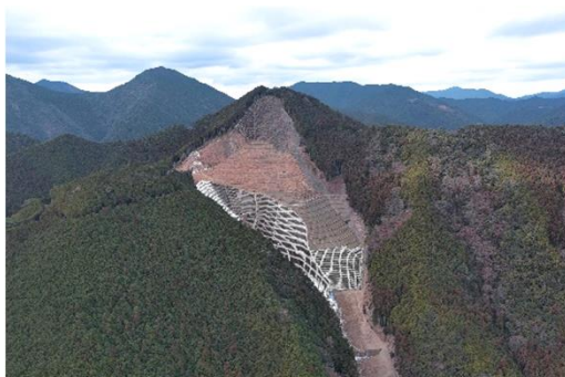
【山腹工】かみへいじがわ (田辺市 紀伊田辺地区：上平治川区域)
