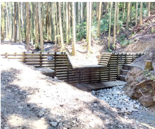
紀泉高原国有林 木製床固工
