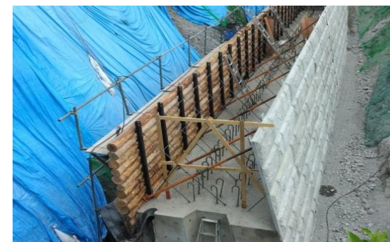
令和7年度溪間工事における存置型枠の 木材利用の状況(大山国有林：大山町)
