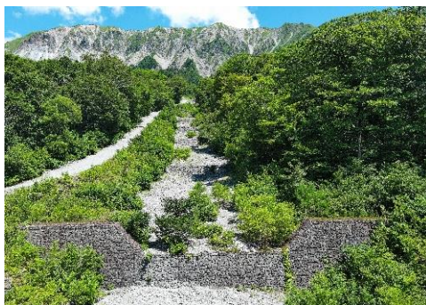
大山三ノ沢溪間工施工地（大山国有林：大山町）
