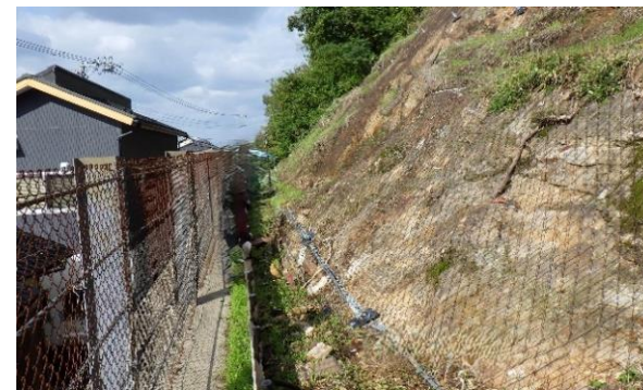
山腹工施工地 きゅうしょうざん （旧城山国有林：鳥取市）
