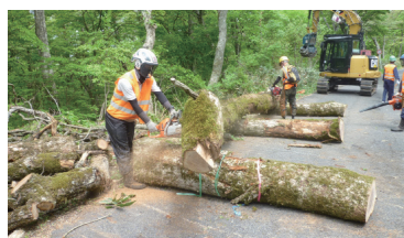
危険木の除去（作業中）
