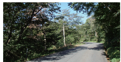
危険木の除去（作業後）
