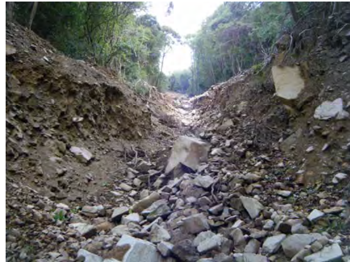
写真① 高松山ヶ-3 治山ダム工計画箇所
