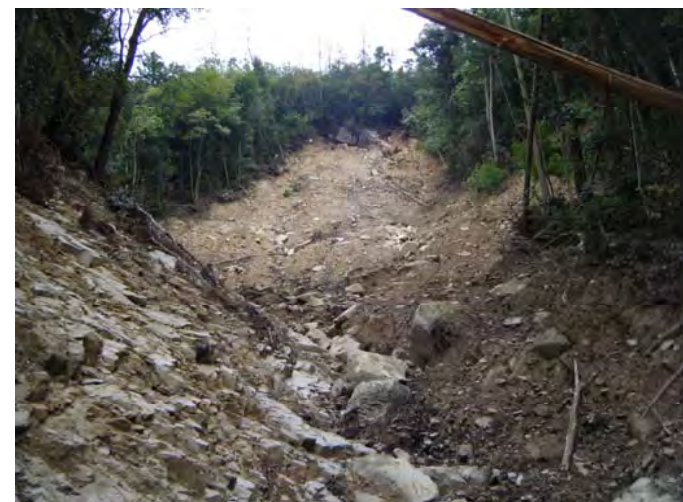
写真⑤ 高松山林-6-2 山腹工Ⅱ型計画箇所
