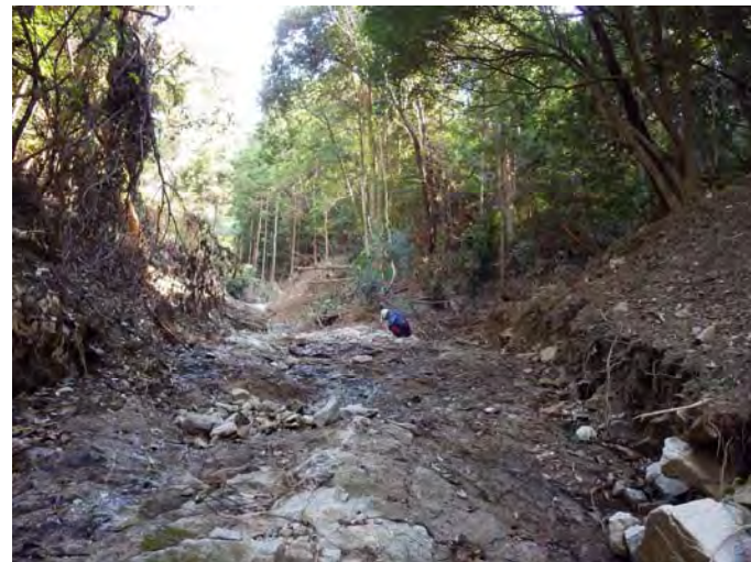
写真③ 登龍ケ-1 治山ダム工計画箇所
