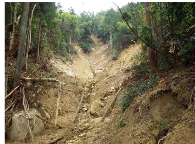
写真③ 高松山林-6-2 山腹工Ⅱ型計画箇所
