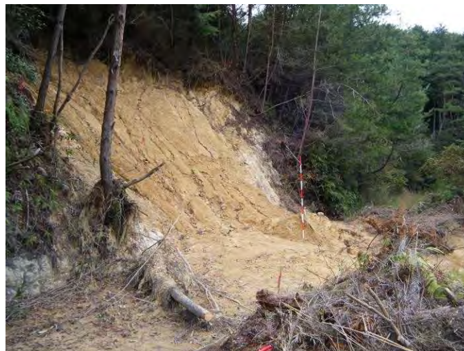
写真⑥ 東山林-5 山腹工 I 型計画箇所
