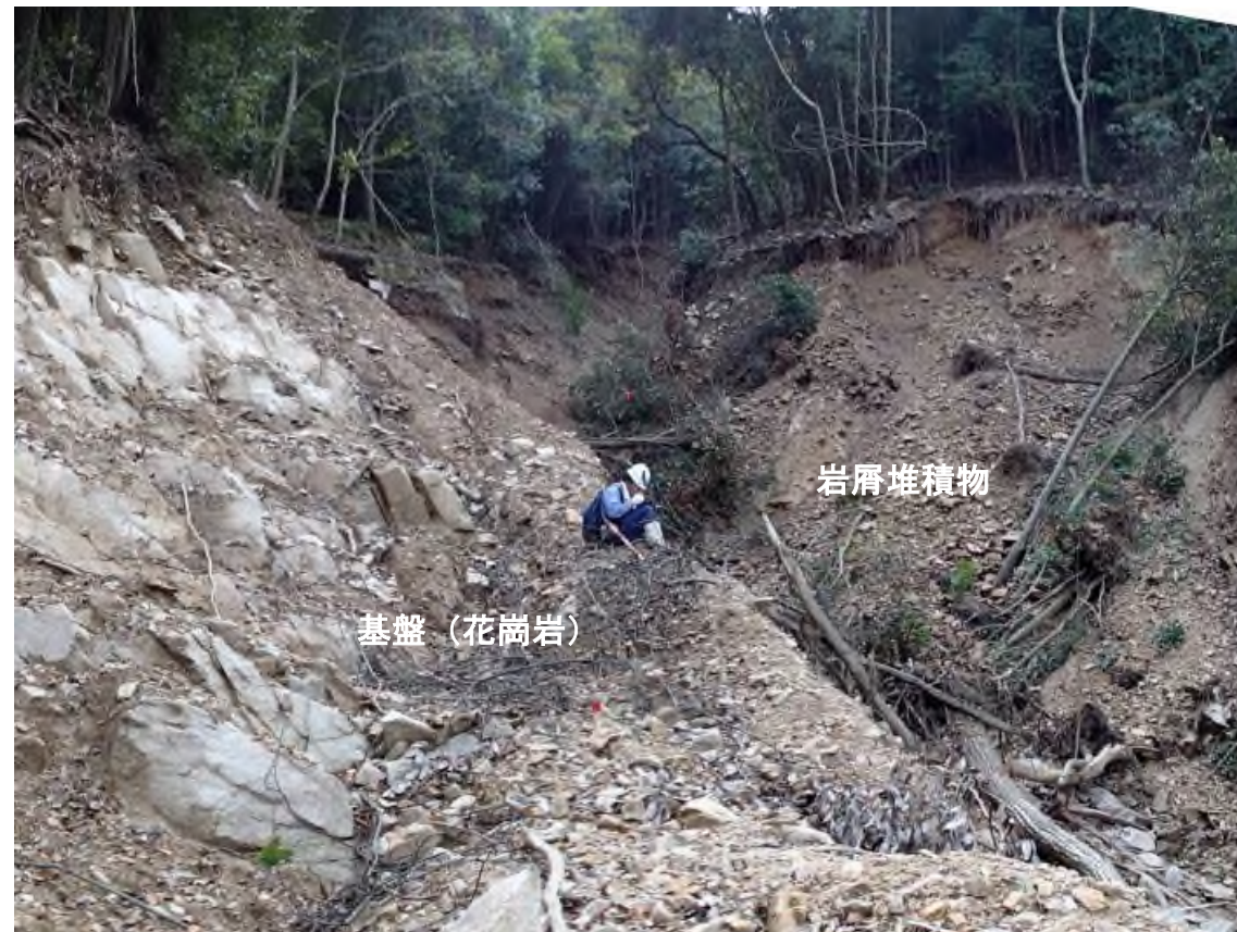
写真 3.1.4-B 高松山 12 号地(ケ-3) 移送域の状況 右岸側には花崗岩が、左岸側には岩屑堆積物が厚く堆積
