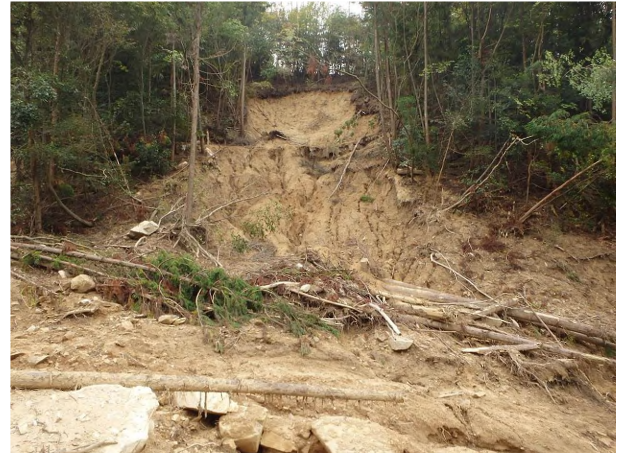
写真 3.1.1-B 高松山6号地(ホ-15) 崩壊源 a-5 を本流から撮影 斜面浅層部がボトルネック状に崩壊し、下流域で侵食が拡大。
