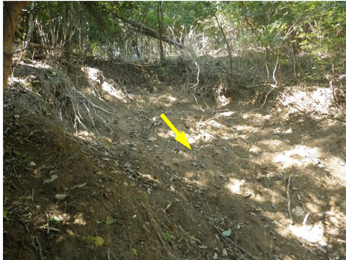
写真 3.1.5-A 美濃越 支流発生域 C 崩壊源 滑落崖高さ 2m。粘性土が露出。
