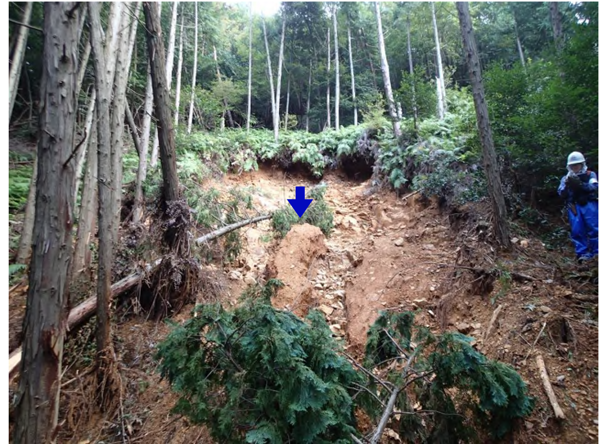
写真 3.1.5-C 高松山 2 号地 (ホ-1-2) 崩壊源 b 崩壊源滑落崖の状況 崩壊源末端のボトルネックになった位置(青矢印)では、表土層が浸食されずに残存。
