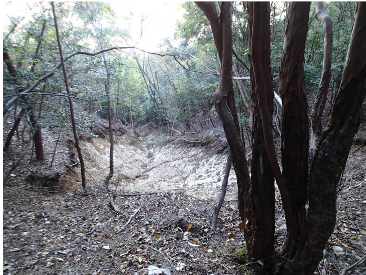
写真 3.1.1-A 高松山12号地(ケ-3)の北東沢 崩壊源を上流から撮影 崩壊源は末端で狭まったボトルネック状で逆しずく型を呈する。
