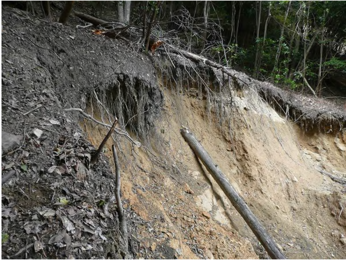
写真 3.1.3-A 高松山 9 号地 (ケ-4) 崩壊源滑落崖の状況 地盤の浅層部が流出しているが、表土部は A 層とともに根系がちぎれずにオーバーハングしている。
