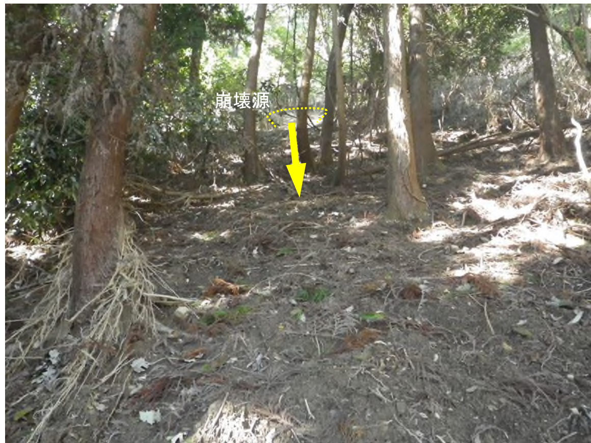
写真 3.1.5-B 美濃越 支流発生域 C 崩壊源下方の流下域 土砂が薄く堆積し、立木に土砂や根系、枝が引っかかっている。侵食は認められない。
