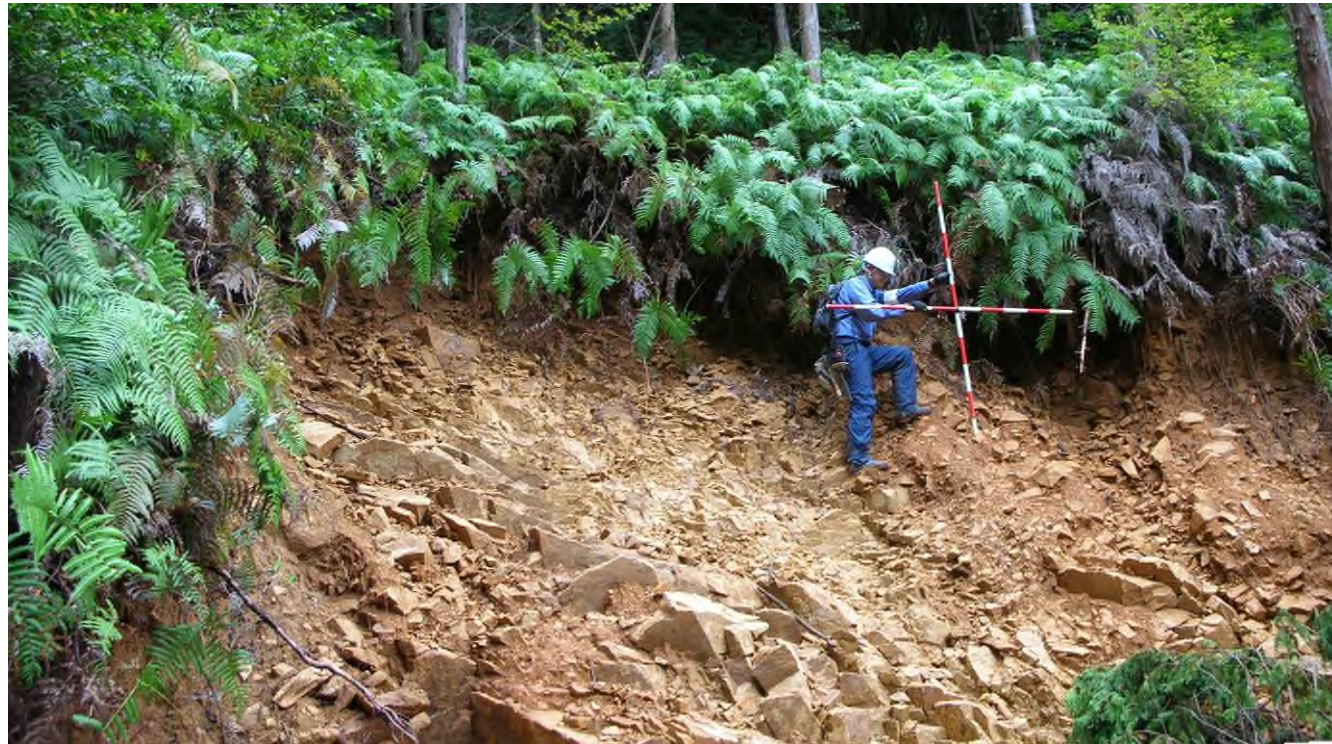
写真 3.1.2-A 高松山 2 号地 (ホ-1-1) 崩壊源 b 崩壊源の状況 崩壊面には割れ目に富んだ花崗岩が露出、滑落崖にはその上位を岩屑堆積物、表土が覆う。
