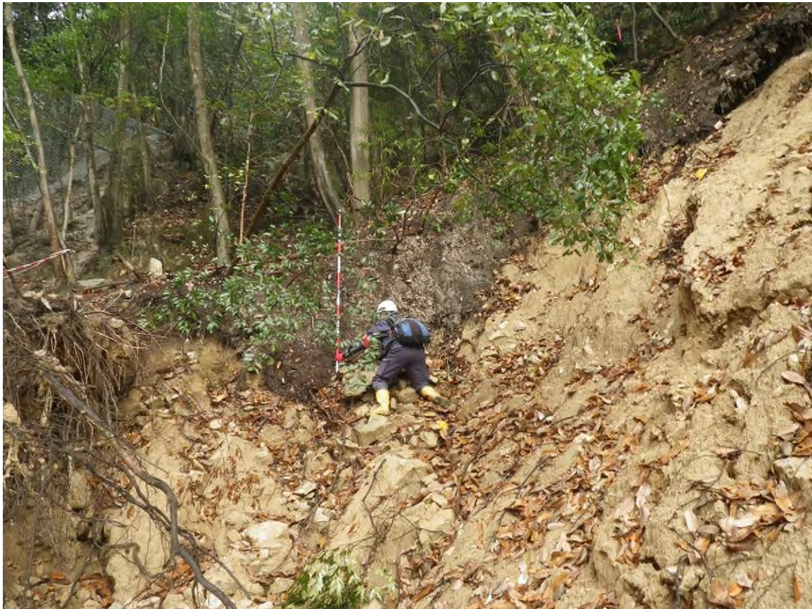
写真 3.1.3-B 宇那木山 S46-1 谷止工下流左岸 表土層下位の砂層が流出し表土層が垂れ下がっている。
