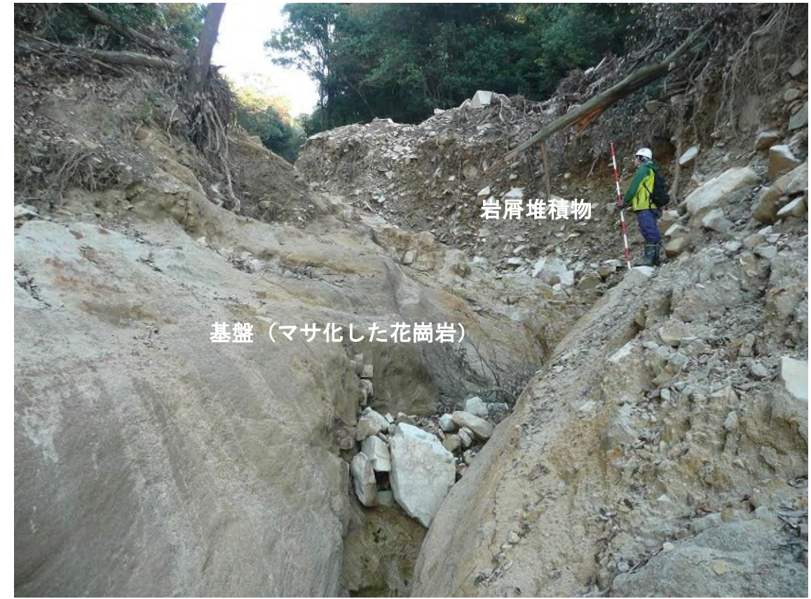
写真 3.1.4-C 高松山 9 号地(ケ-4) 移送域の状況 右岸側には花崗岩が、左岸側には岩屑堆積物が分布
