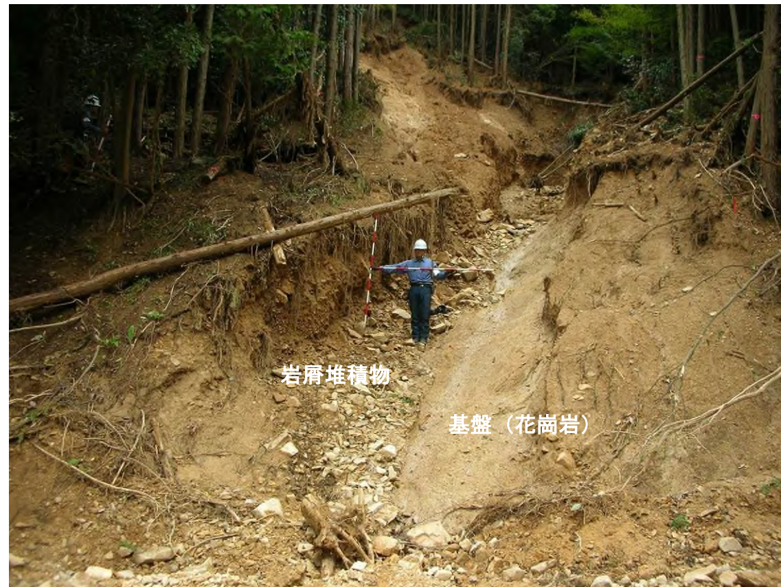
写真 3.1.4-A 高松山 2 号地(ホ-1-2) 移送域の状況 左岸側にはカタクレーサイト化した花崗岩、河床～右岸側には岩屑堆積物が分布
