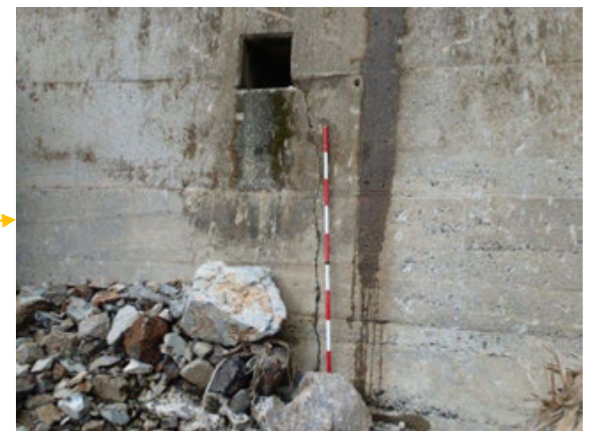
写真④ クラック (最大) 15mm
