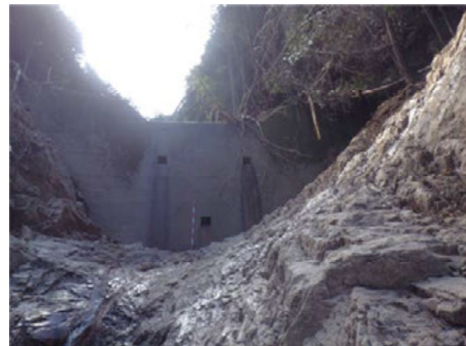
写真 8.2.1 治山施設正面 (S40 施工) (大きな変状は確認されない)
