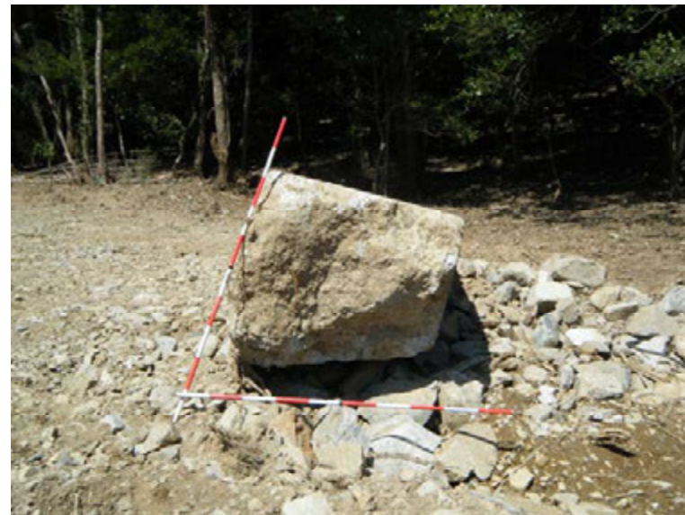
写真② 流失コンクリート片 (1.0m×4.8m×1.2m) (写真撮影日 2014年10月8日)
