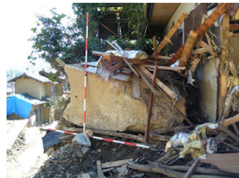
写真④ 流失コンクリート片 (1.2m×4.0m×1.0m) (写真撮影日 2014年10月8日)
